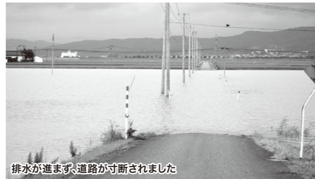
水路は機能不全となり、圃場の排水進まず
